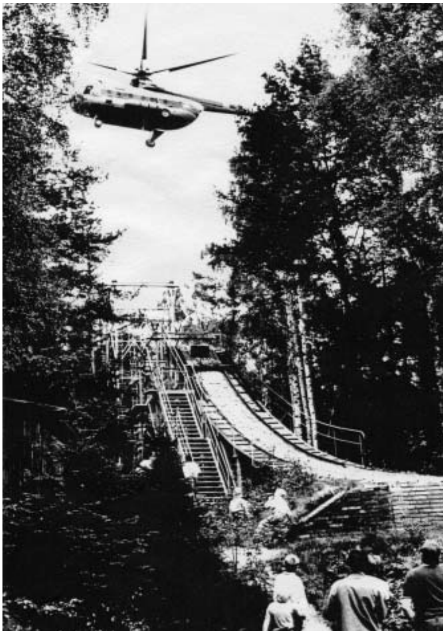
1989: Montage des stabilen Stahlgerüsts per Hubschrauber
